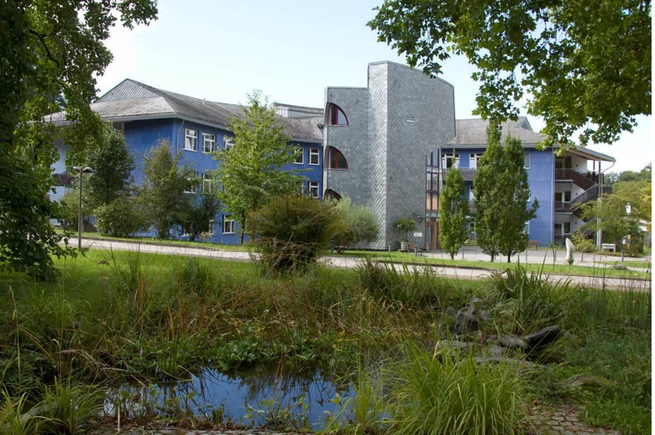
Abbildung: Stationsgebäude Lukashauss
