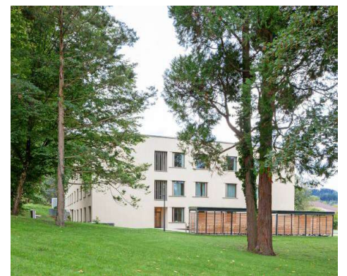
Der dreigeschossige Neubau fügt sich in das Höhenprofil des alten Baumbestands der Parkanlage ein. Die teils seltenen Bäume konnte komplett erhalten werden.
